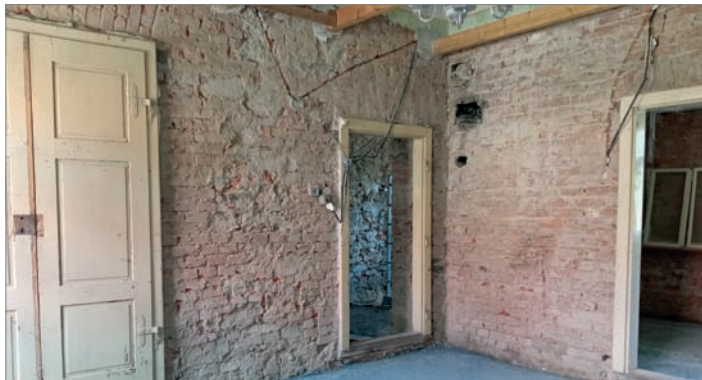
Rekonstrukce bytu v budově bývalé školy, Velký Bor č.p. 32.
