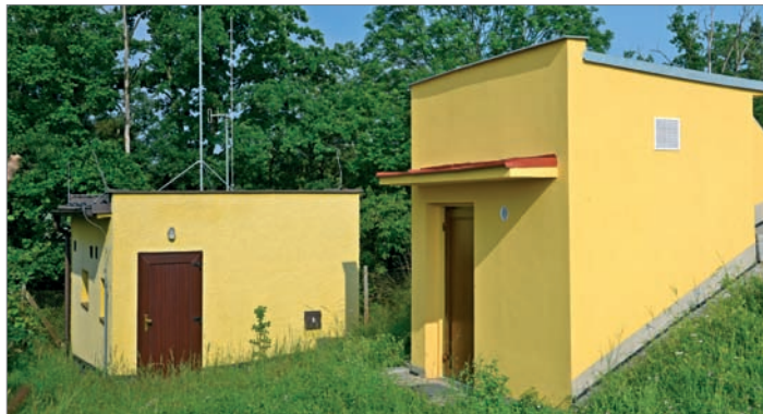
Opr. vodojemu (fasáda, izolace zdiva, dveře) na Hořicích, Strunkovice.
