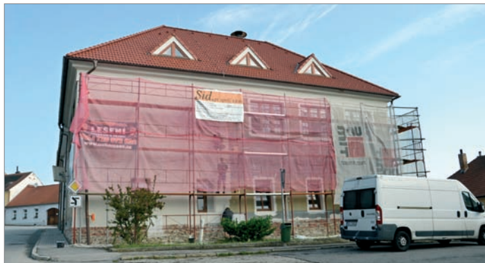
Oprava fasády budovy 1. stupně ZŠ ve Strunkovicích.
