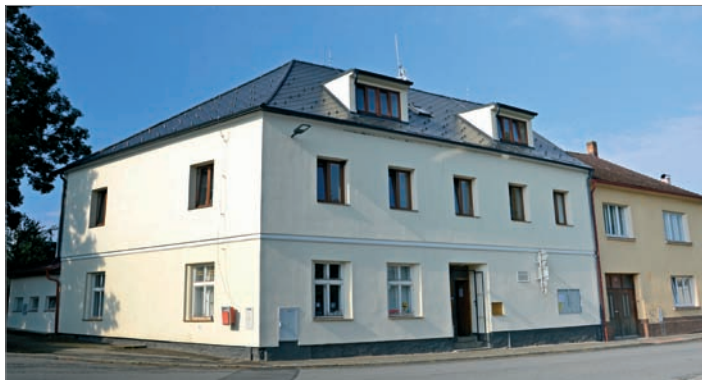
Foto: 4x Karel Matějka • Oprava fasády domu Strunkovice č.p.95.
