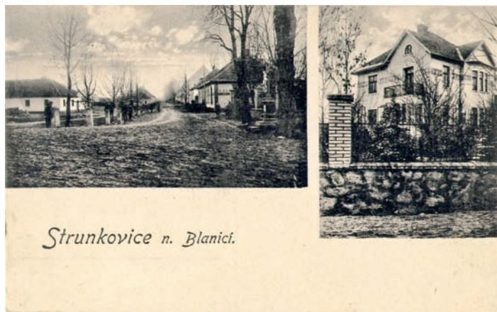
Cesta od mostu, vpravo vila rady Ackerleho (pohlednice 1927)
