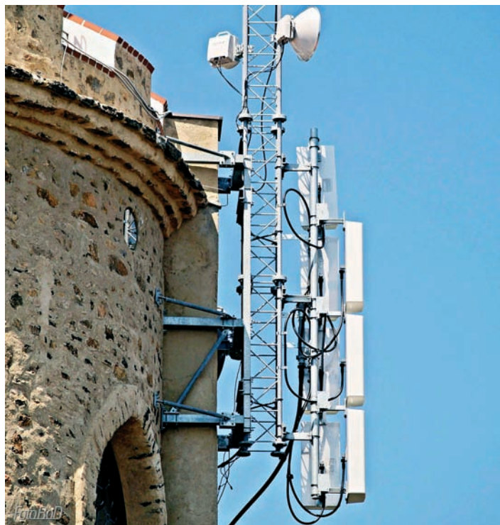
Antenní systémy MUX4 a MUX RS7 na rozhledně na Kleti.
