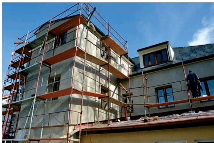
Fasáda Strunkovice č. p. 95.
