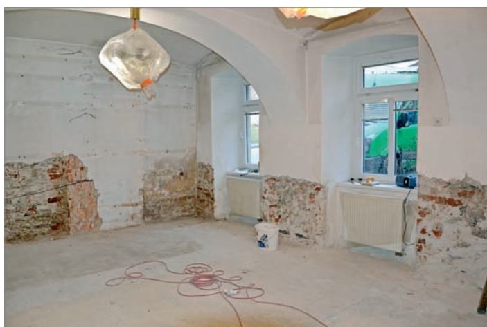
Rekonstrukce obřadní místnosti.
