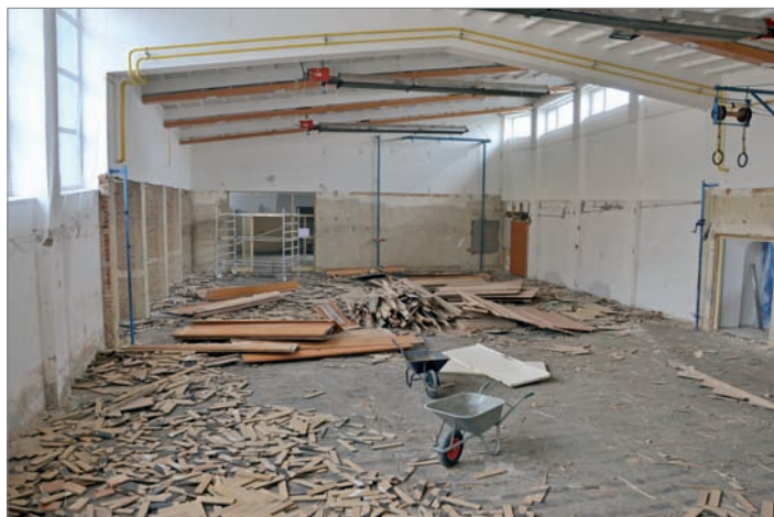
Začátek rekonstrukce tělocvičny KD.
