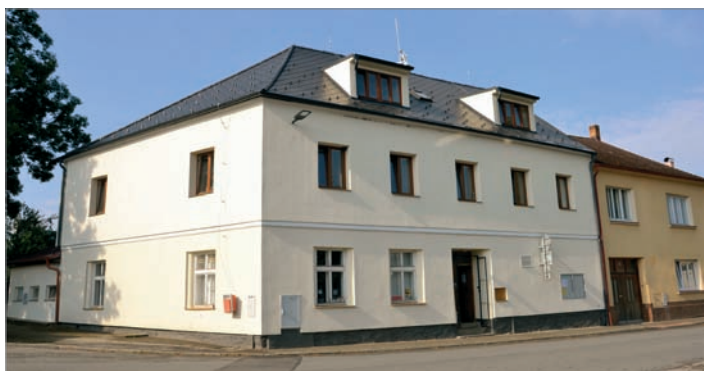
Foto: Karel Matějka • Nátěry oken, oprava soklu, č.p. 95 Strunkovice
