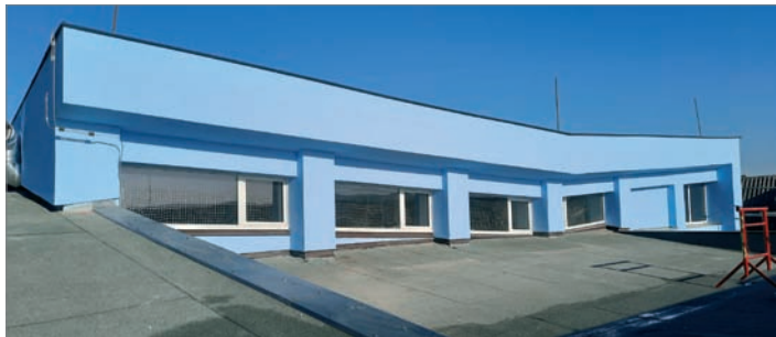
Foto: Karel Matějka • Zateplení stěn KD
