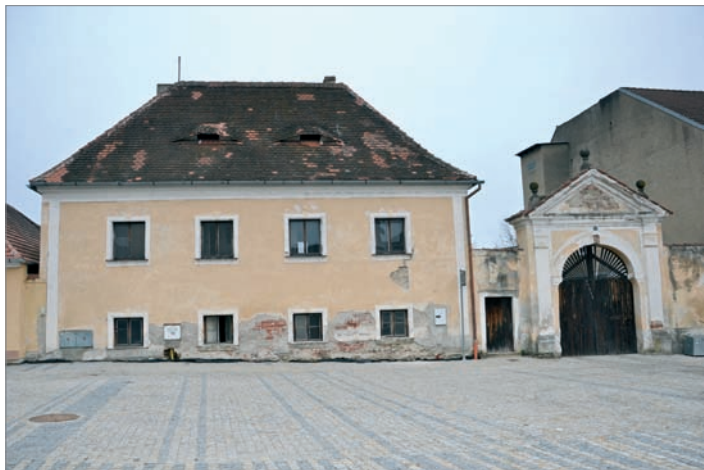
Foto: 2x Karel Matějka • Fara č.p.1, rekonstrukce fasády, výměna oken, výměna střešní krytiny, nadkroevní izolace, oprava komínů, výměna okapů a okapových svodů.
