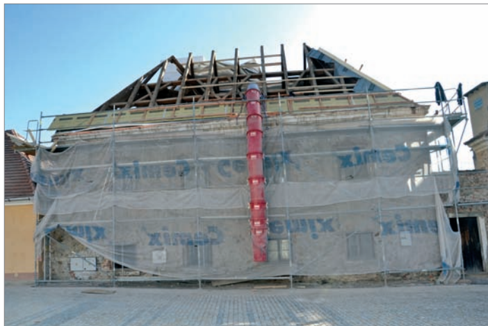
Foto: 2x Karel Matějka • Fara č.p.1, rekonstrukce fasády, výměna oken, výměna střešní krytiny, nadkroevní izolace, oprava komínů, výměna okapů a okapových svodů.
