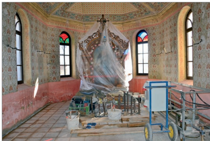
Foto: Karel Matějka (Oprava kaple Svojnice)
