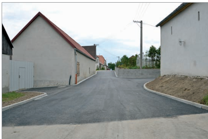
Foto: Karel Matějka (Oprava místní komunikace ve Velkém Boru)
