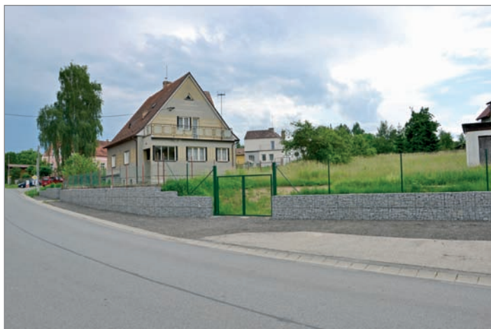
Foto: Karel Matějka (Výstavba opěrné zdi v ul. Protivecká)
