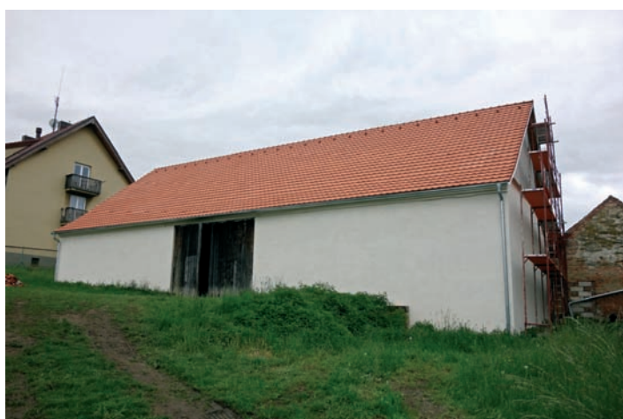
Foto: Karel Matějka • Sběrný dvůr (rekonstrukce střechy, podlah, fasády...)
