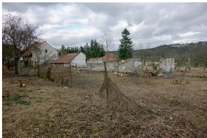
Foto: Karel Matějka • Demolice prasečáku a úprava pozemků, Velký Bor
