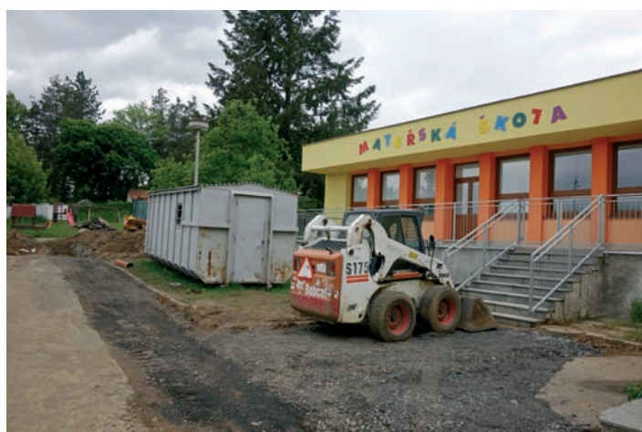
Foto: Karel Matějka • Strunkovice n. Bl. - obnova kanalizace v areálu ZŠ a MŠ
