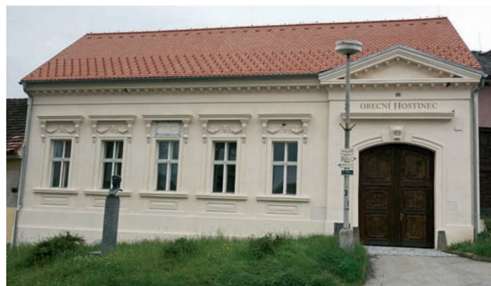
Foto: Karel Matějka • Revitalizace rodinného domu B. Havlasy Strunkovice nad Blanicí
