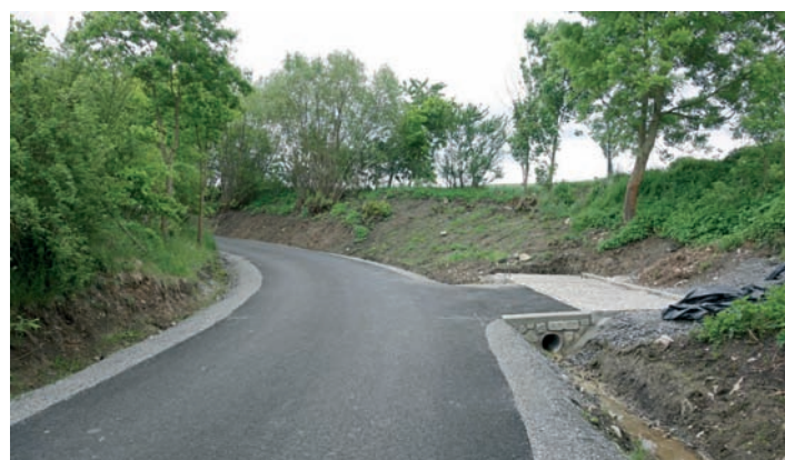
Foto: Karel Matějka • Oprava místních komunikací v k.ú. Protivec
