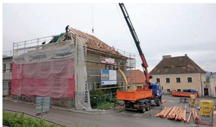
Foto: Karel Matějka • Oprava školních objektů Strunkovice n. Bl. (Budova 1. stupně ZŠ)
