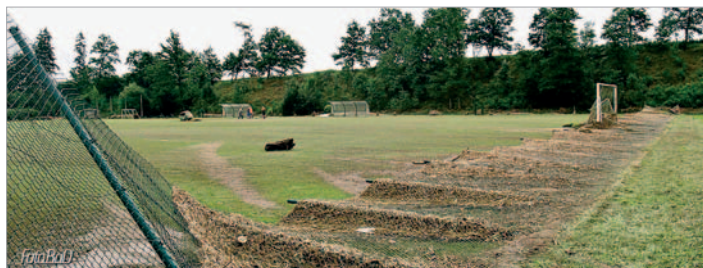
Pohled na plot fotbalového hřiště stržený letošní povodní.
