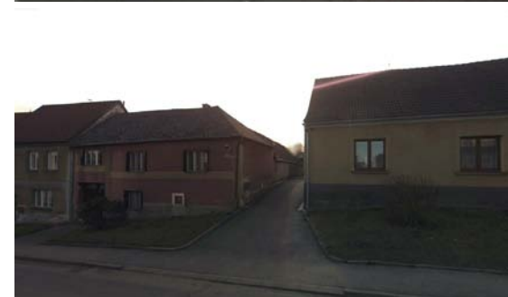
fotografie stávajícího stavu
