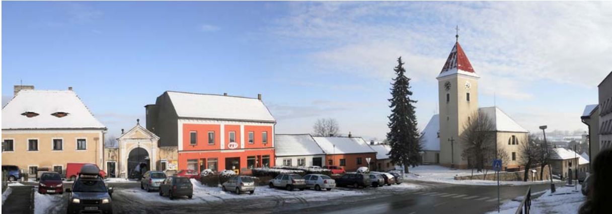
fotografie stávajícího stavu
