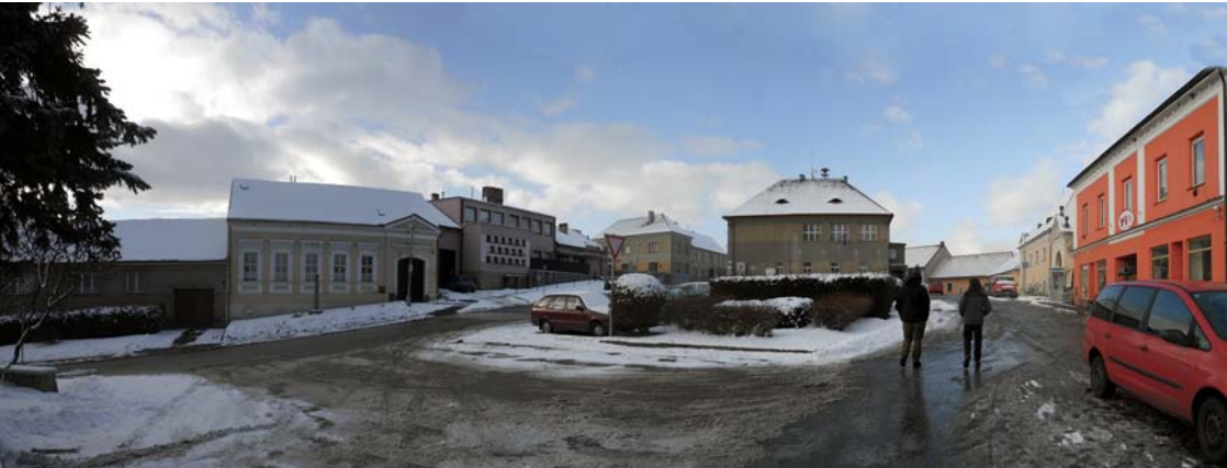
fotografie stávajícího stavu
