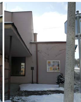
fotografie stávajícího stavu
