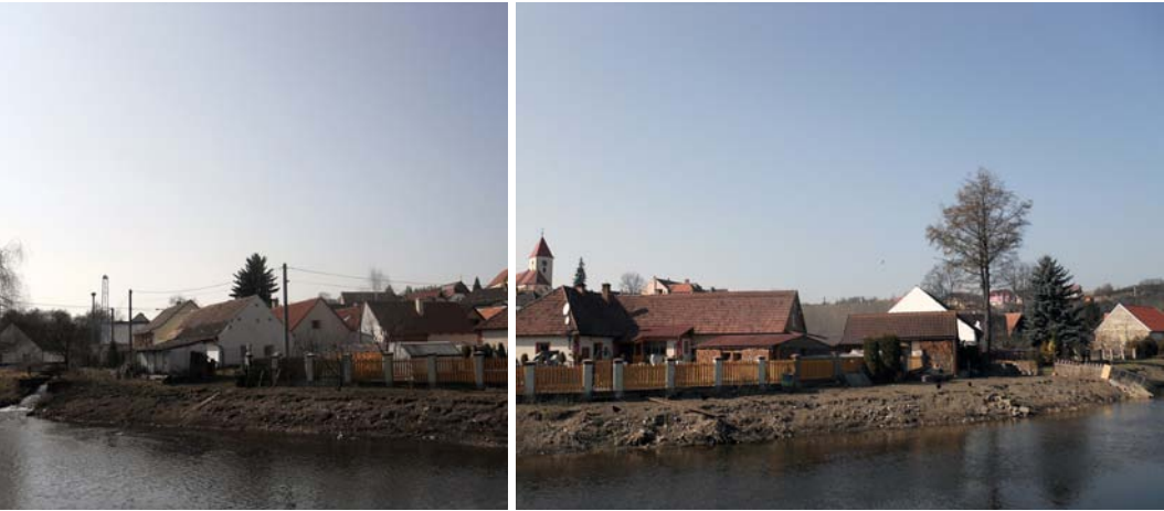
fotografie stávajícího stavu
