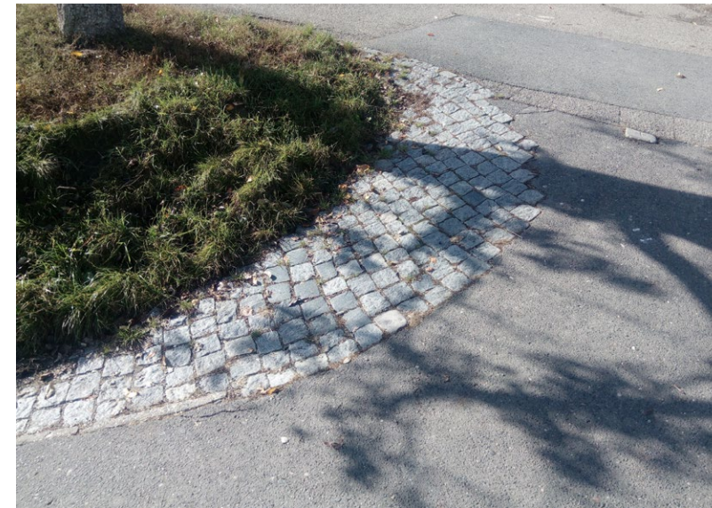
Doplnění kostkou - záplaty a drobné opravy jsou v souladu s venkovským charakterem. Důraz by měl být kladen ale na kvalitní materiál - žulová kostka, která v budoucnu může nahradit celou asfaltovou plochu.
