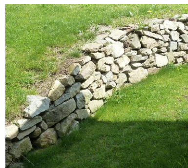
příklad ukloněné zidky skládané nasucho
