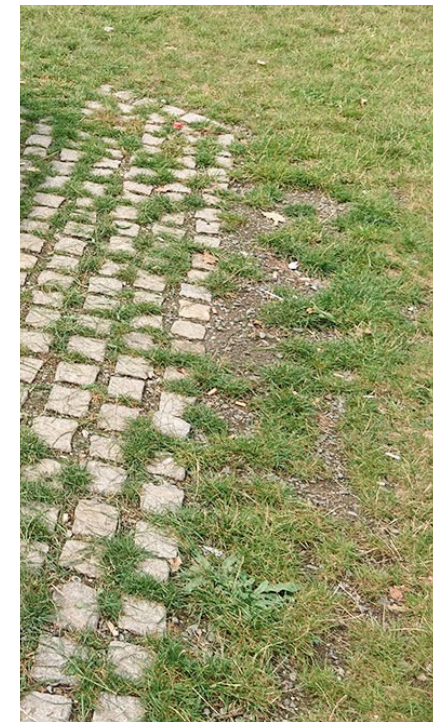
Měkký přechod trávníku do dlažby - příklad zpevnění plochy s extenzivním využitím - např. plochy pod lavičkami.
